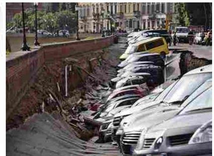
Il cedimento è avvenuto attorno alle 6.30 e ha coinvolto un ventina di auto in sosta per un tratto di 200 metri in Lungarno Torrigiani. A provocare lo sprofondamento la rottura di un tubo dell'acqua. Una parte di manto stradale è crollata dentro la voragine. Il sindaco: «Danni pesantissimi»
