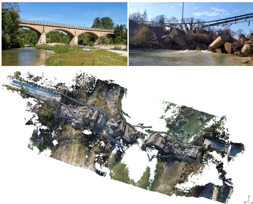
**Figura 1.** Immagini del ponte Guastacconcio (CH) sito nel comune di Paglieta (CH): in alto, immagini prima e a seguito del collasso avvenuto in data 13/02/2023, in basso modello fotogrammetrico da UAV effettuato in seguito al collasso.
