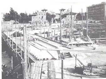
20 agosto 1934, posa della solista del primo piano.
