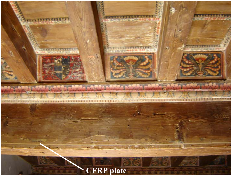
Figure 9-1 – Strengthening intervention in Palazzo Nobili (Designer: dr.ing. M. Martinelli - Legno Più S.r.l.).
