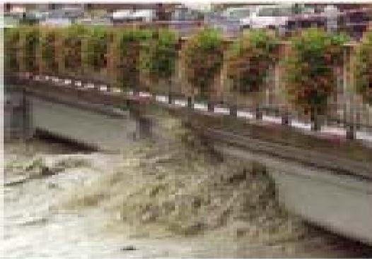
Figura 7.1: Franco idraulico insufficiente
