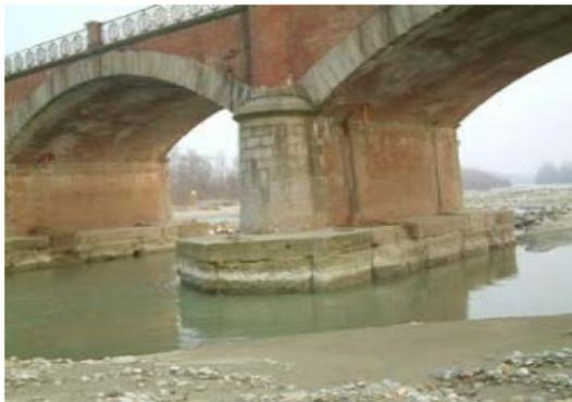
Figura 7.3: Scalzamento al piede delle pile
