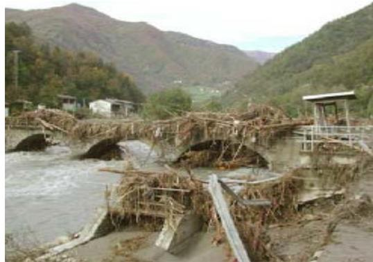
Figura 7.2: Interferenza con il corso d'acqua
