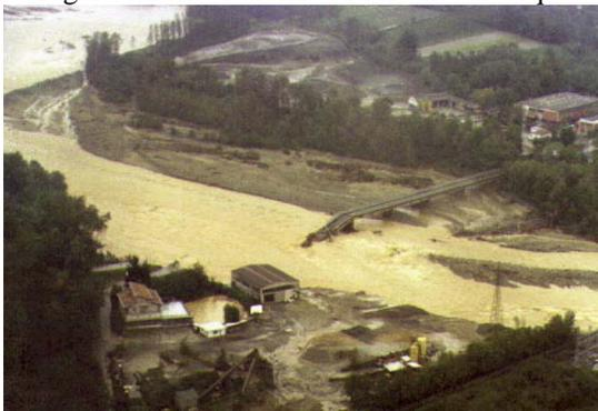
Figura 7.4: Interferenza con la morfologia del corso d'acqua
