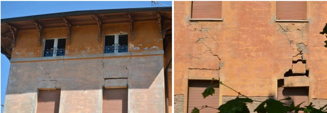
Fig. B-2 Danno nelle fasce di piano, con attivazione di meccanismi sia di pressoflessione che taglio.
