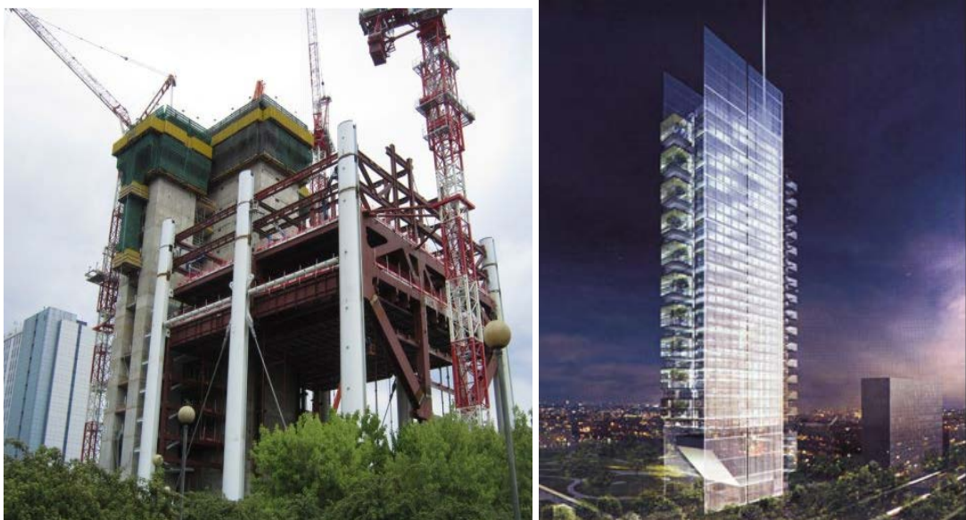
Figura 1-2 –Torre Intesa San Paolo, Torino, Italia, (2010/in costruzione). Altezza: 218 m; classe di resistenza: C70/85
