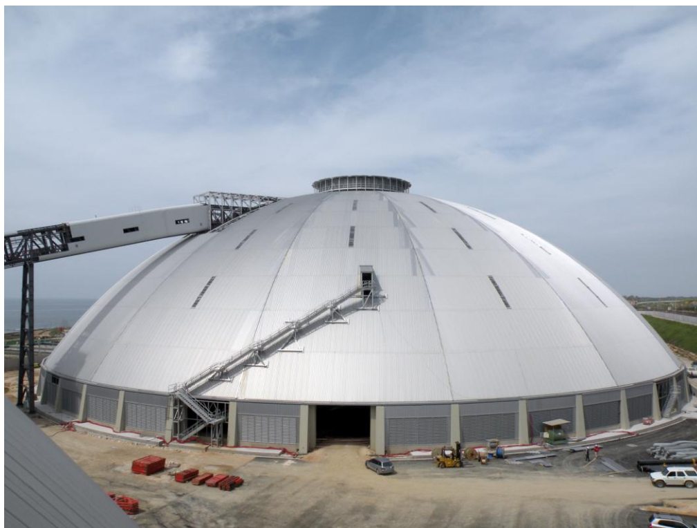
Figura 0-7.8: una delle due cupole geodetiche con diametro di 144 m dell'impianto Enel di Torrevadalliga Nord (Civitavecchia).
