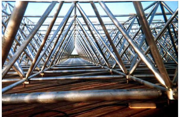
Figura 0-7.4: dettagli della copertura del Centro Congressi di Alghero.
