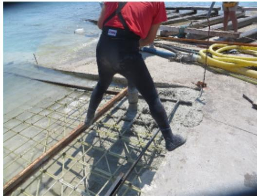
Figura 10-8. Applicazione di barre di FRP come armatura in rampe di alaggio di barche (per gentile concessione di Sireg Geotech).
