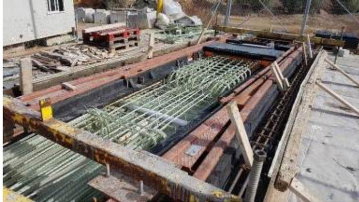
Figura 10-9. Esempio di applicazione di barre di FRP come armatura di elementi esposti ad interferenze elettromagnetiche (per gentile concessione di Sireg Geotech).
