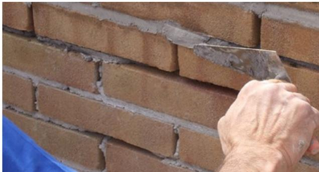
Figura 10-2 Applicazione di barre di FRP come armatura per la ristilatura dei giunti in paramenti murari ([www.mapei.it](http://www.mapei.it)).
