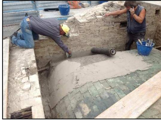
Figura 2.2 – Refuerzo con red de fibra de basalto en hoja instalado con revoque difuso de mortero a base de cal hidráulica en el exterior de una bóveda..
