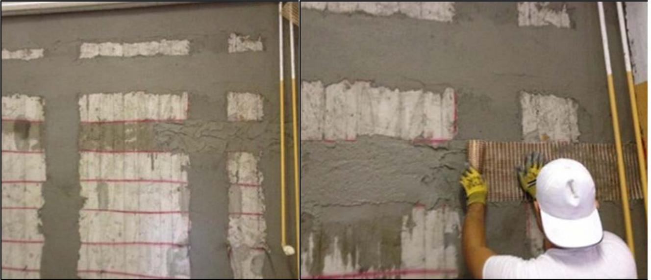
Figura 2.17 – Refuerzo a cortante de muros de hormigón armado.
