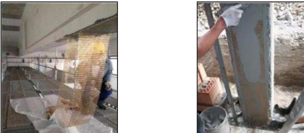
Figura 2.10 – Refuerzo a flexión de una viga y de una columna con red de PBO.
