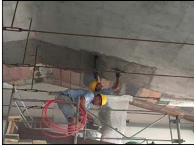
Figura 2.19 – Refuerzo de losa (anti-hundimiento) con red de fibra de vidrio AR y mortero.
