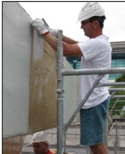
Figura 2.12 – Refuerzo a cortante de una viga con red de PBO.
