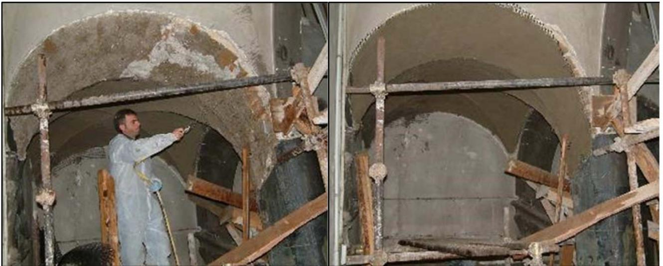
Figura 2.5 – Refuerzo al interior de bóveda en mampostería con red de fibra de vidrio AR y mortero.
