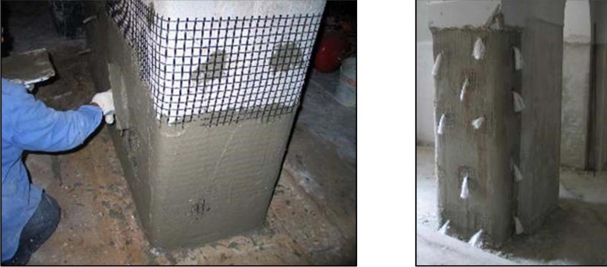
Figura 2.9 – Confinamiento de columna de mampostería con red de vidrio AR.
