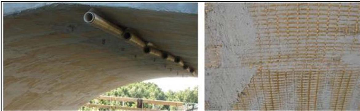
Figura 2.22 – Refuerzo con redes de PGO al interior de un puente con arcos de hormigón
