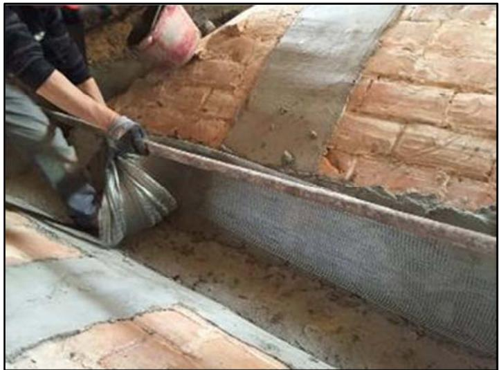
Figura 2.3 – Aplicación de bandas de tejido de metal galvanizado unidireccional y mortero para refuerzo en el exterior de bóvedas en mampostería.
