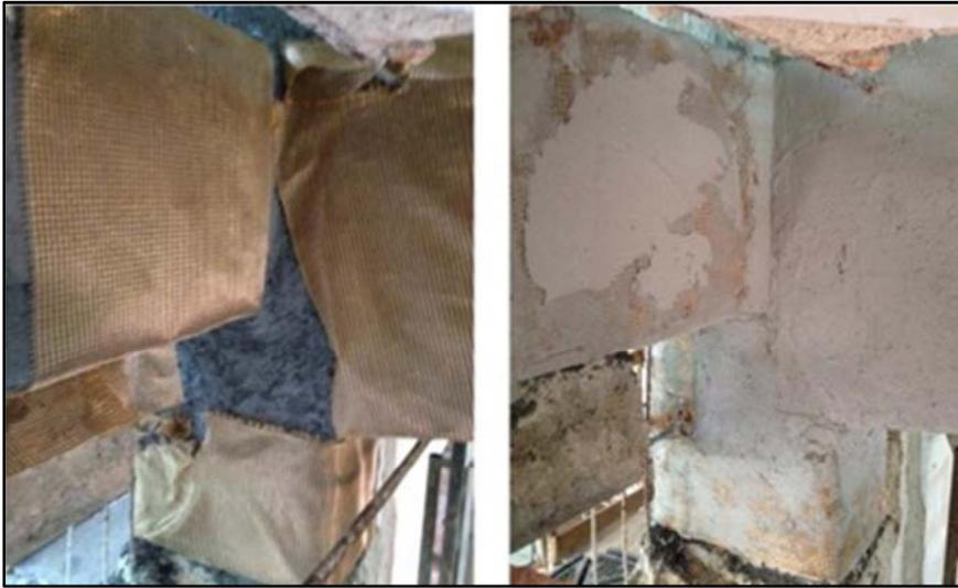
Figura 2.15 – Refuerzo de conexiones vigas-columna.
