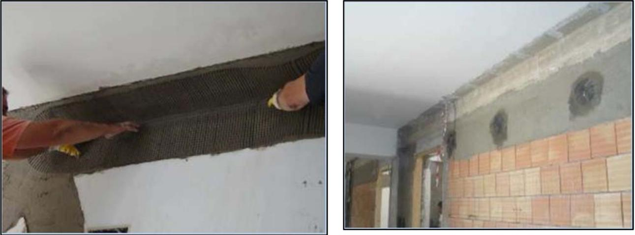
Figura 2.21 – Protección anti-vuelco de panel de mampostería con diferentes tipos de redes y conectores.
