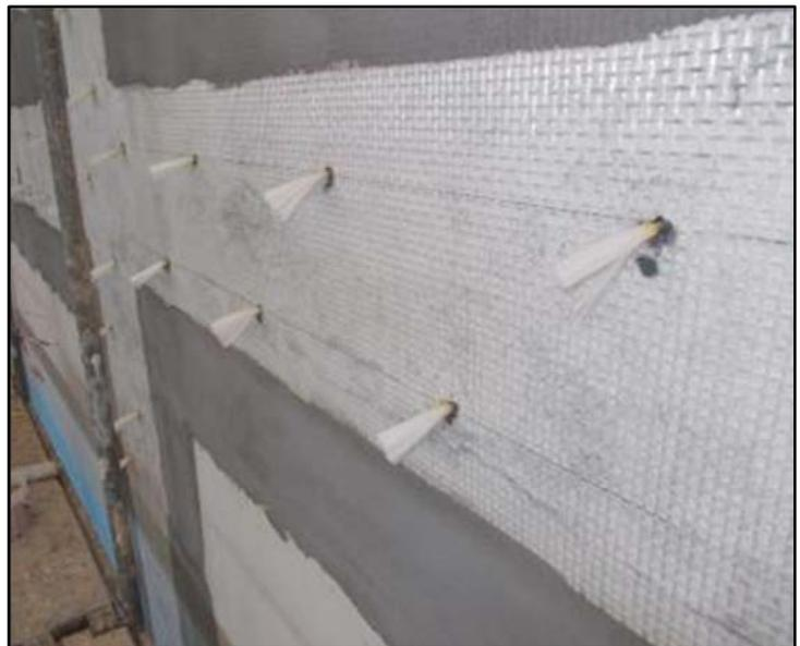
Figura 2.20 – Refuerzo anti-vuelco de paredes con un sistema FRCM hecho de red de fibra de vidrio, mortero, promotor de adherencia e incrustaciones de fibra de vidrio.
