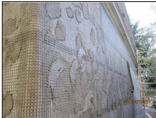
Figura 2.1 –Refuerzo de paneles de mampostería con red de basalto.
