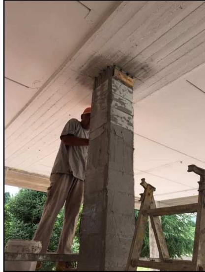
Figura 2.13 – Confinamiento de columna con tejido unidireccional realizado con red de acero galvanizado de alta resistencia y mortero de cemento.
