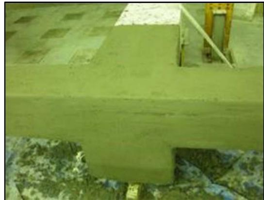
Figura 2.16 – – Refuerzo de conexiones vigas-columna con tejido metálico galvanizado unidireccional y mortero de cemento
