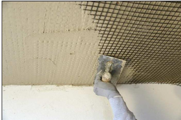
Figura 2.18 – Refuerzo de una losa (anti-hundimiento).
