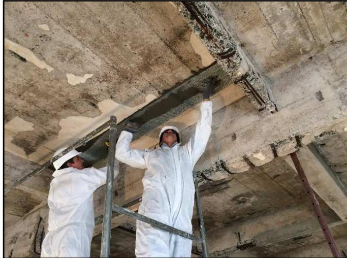
Figura 2.11 – Refuerzo a flexión de viga con bandas de tejido unidireccional hecho con redes de acero galvanizadas de alta resistencia y revoque de mortero de cemento.
