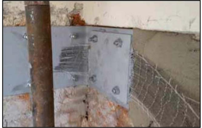
Figura 2.6 – Bordillos laterales hechos con tejidos de PBO y acero.
