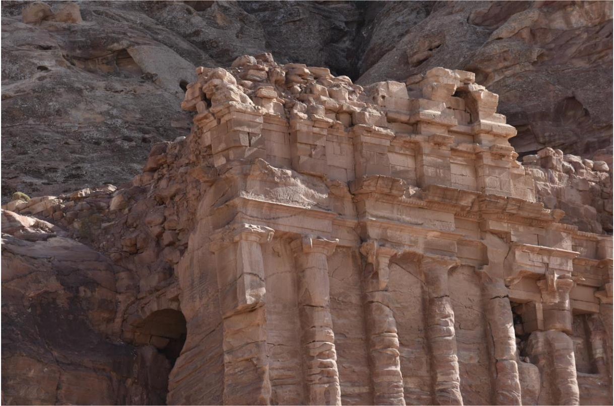
**Figura 5** Particolare della Tomba Palazzo dove evincono le numerose fratture presenti sul monumento. Di particolare attenzione debbono richiedere le strutture in elevato sopra la parte scolpita della parete rocciosa.
