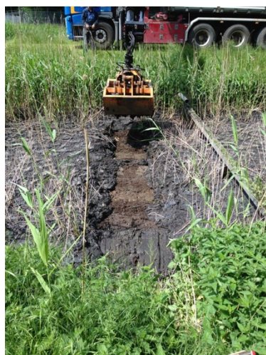
Figura 33 Impianto di Karlebo
