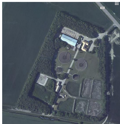
Figura 28 Impianto di Fårevejle
