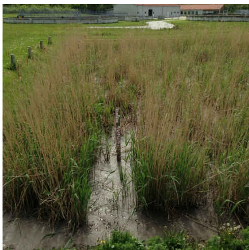
Figura 11 Impianto di Sorø
