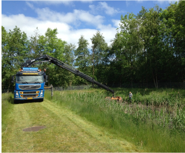
Figura 35 Impianto di Karlebo
