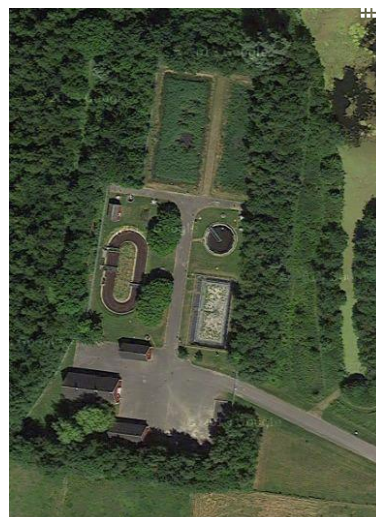
Figura 32 Impianto di Karlebo
