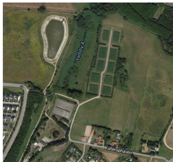
Figura 18 Impianto di Kallerup
