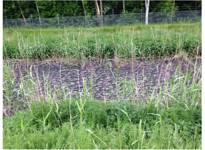
Figura 36 Impianto di Karlebo
