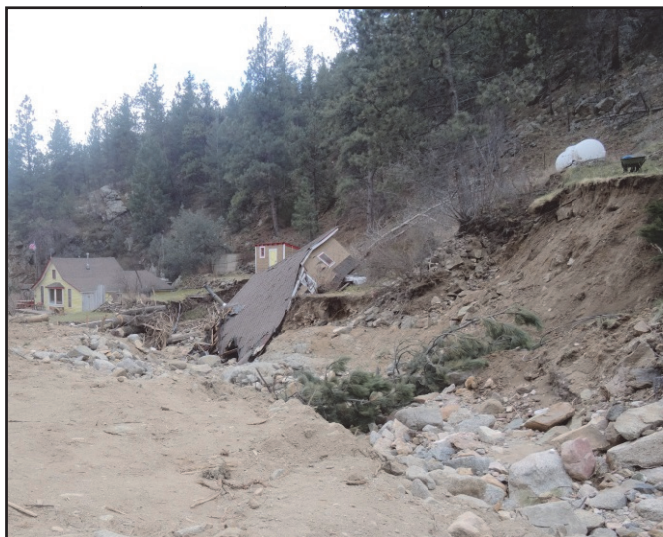
Figura 9 - Un'abitazione localizzata sulla sponda di un alveo torrentizio, e distrutta da un debris flow durante l'alluvione del settembre 2013. L'immagine evidenzia come anche negli USA vi siano edifici nelle zone di pertinenza dei processi fluvio-torrentizi, in forti situazioni di rischio.
